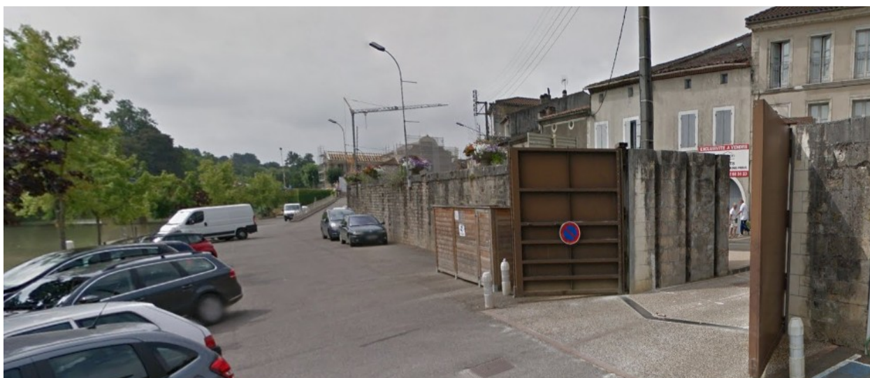
Illustration 108 : Mur maçonné en rive gauche de la Baïse à Condom (Source : Google Street)
