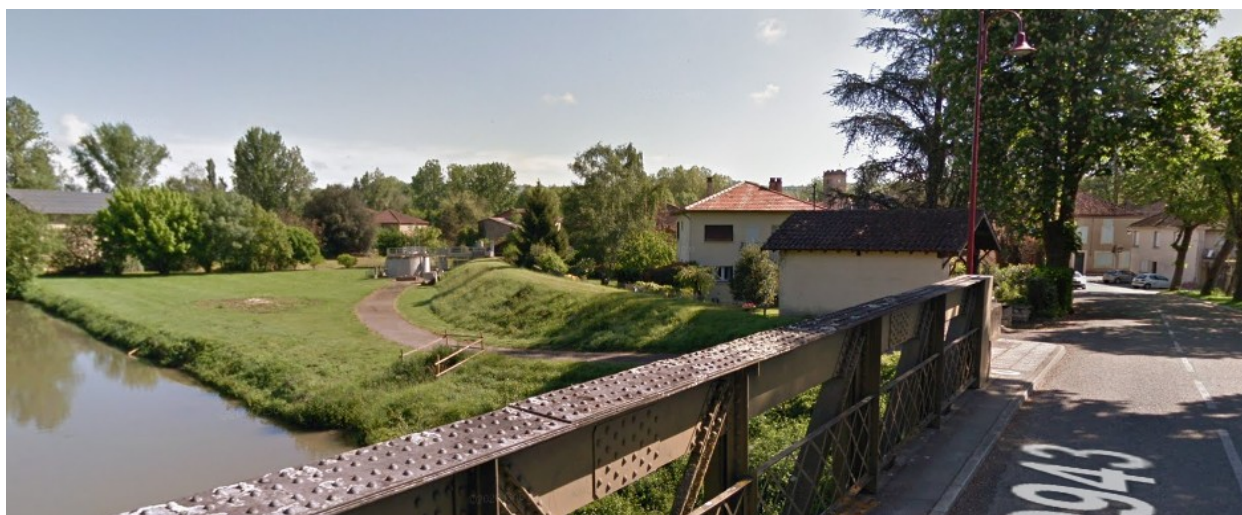
Illustration 109 : Digue en terre en rive droite de la Baïse à l'Isle-de-Noé (Source : Google Street)
