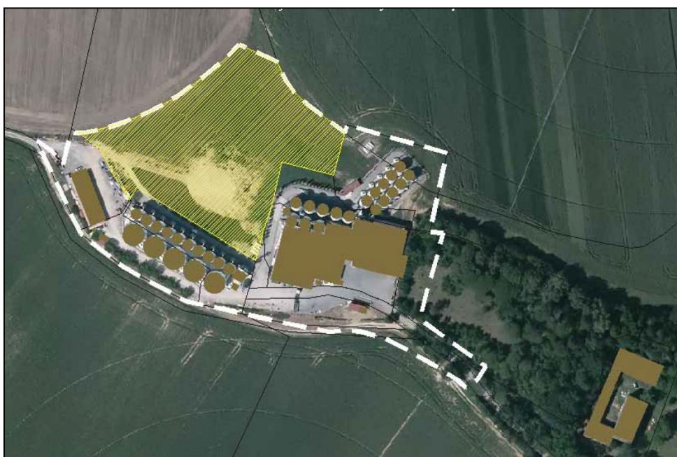
Figure 1 : Vue aérienne du site dans sa configuration actuelle
