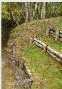
Réfection de berge en génie végétal
