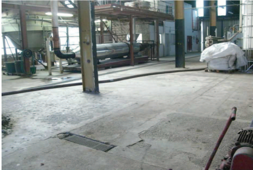
Vue du sécheur depuis l'emplacement de la future colonne
