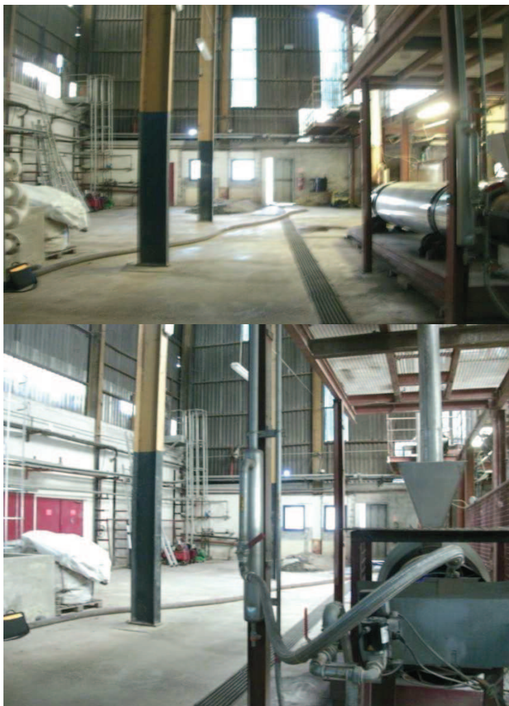
Vue du positionnement des futures colonnes depuis le sècheur
