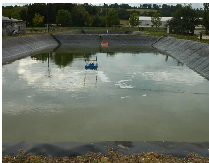
Figure 5 : Vue du bassin d'aération
