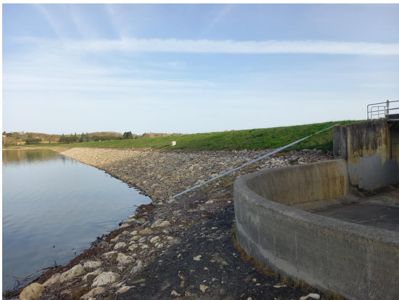
Parement amont et déversoir du barrage d'Astarac
