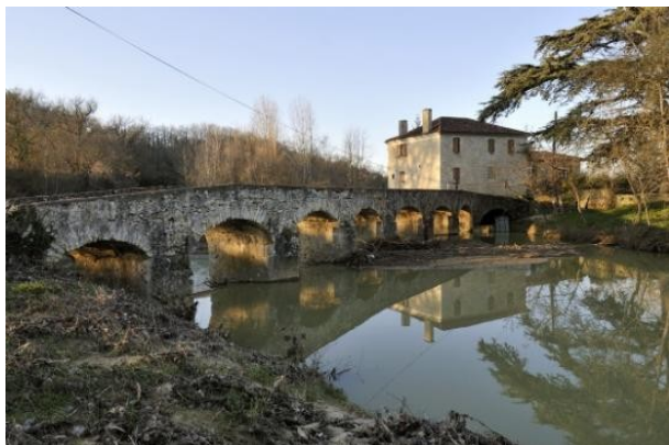
Illustration 76 : Pont barrage de Géleneuve vu depuis l'amont (Source : petit-patrimoine.com)
