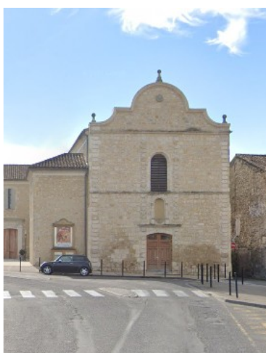
Illustration 74 : Ancienne église des Carmes à Condom (Source : Google Street)
