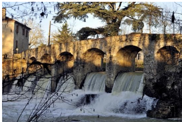
Illustration 77 : Pont barrage de Géleneuve vu depuis l'aval (Source : petit-patrimoine.com)
