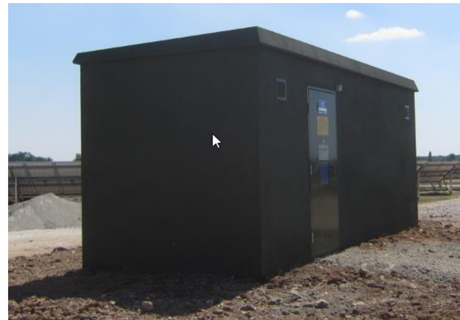
Exemple de poste de conversion « indoor »
