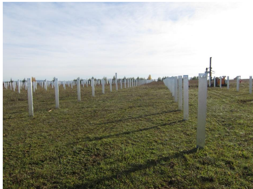
Exemple de pieux battus dans le sol avec une batteuse visible en arrière-plan
