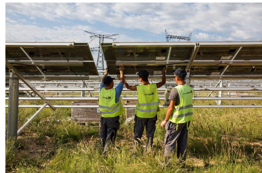
Pose de modules
