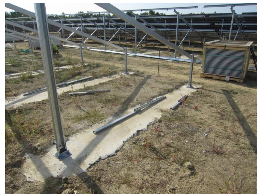
Exemple de longrine béton enterré
