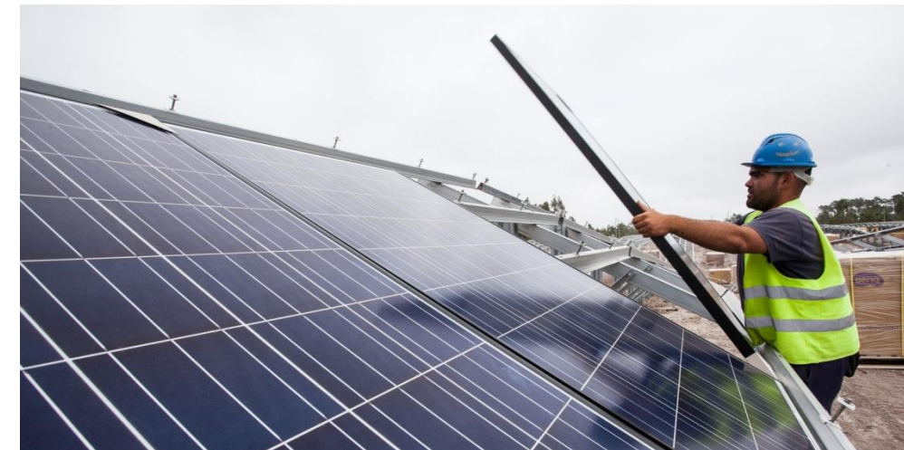
Pose de modules
