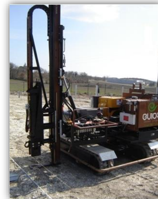
Engin de battage de pieux
