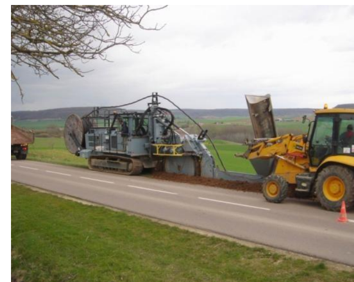
Réalisation d'une tranchée
