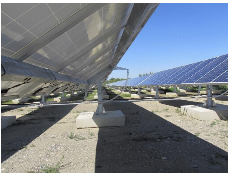
Schéma de principe des fixations avec plots bétons (Source : Axial)
