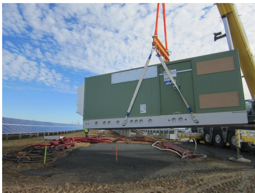
Exemple d'installation de poste de conversion
