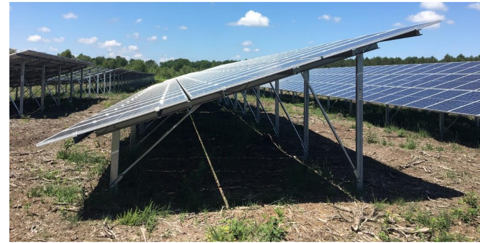
Exemple de structure de tables fixes
