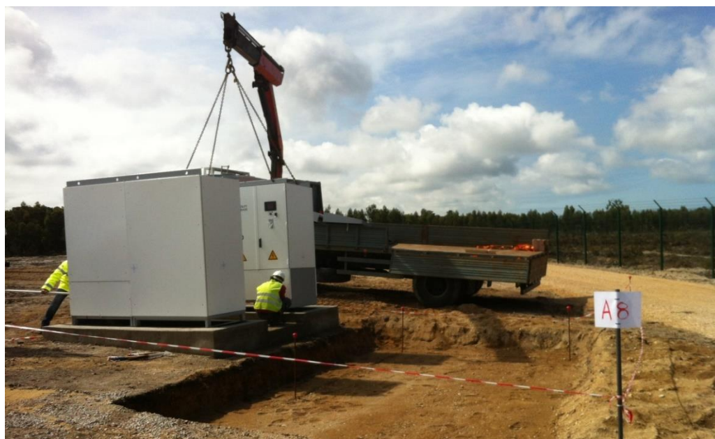
Exemple d'installation de poste de conversion outdoor
