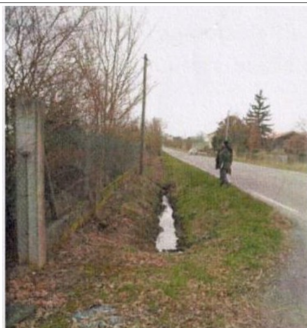
Fossé où se rejettent les eaux sales
