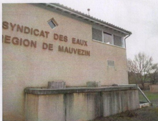
Compartiment de l'inter-ozonation avec accès à droite
