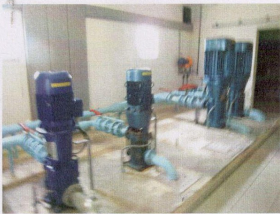
Pompes de refoulement
