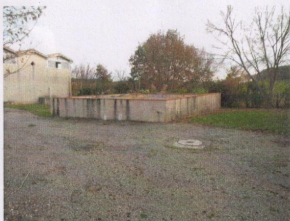
Ancienne bache de stockage
