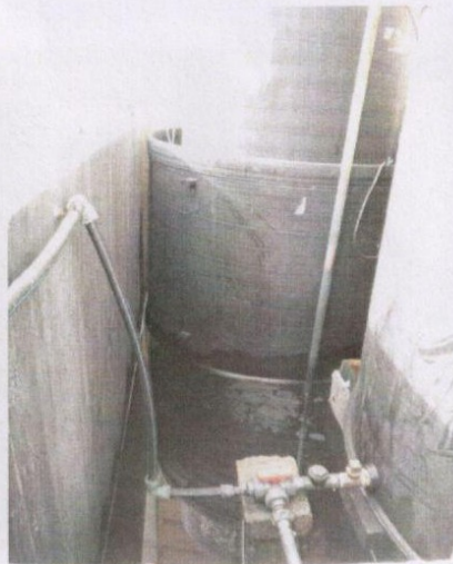
Stockage de réactifs sur bac de rétention
