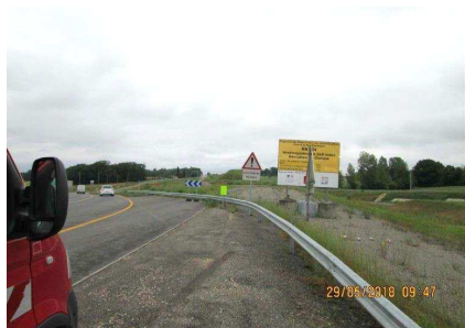
Site 1 : giratoire entre RD 924 et RN 124 direction Gimont
