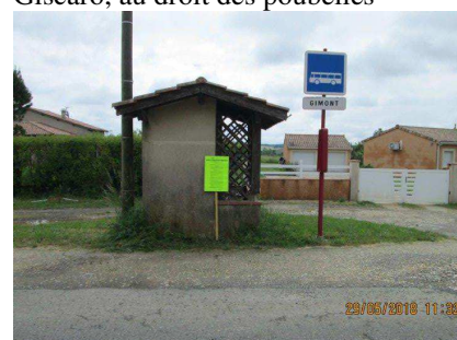
Site 6 : RD 4, abribus
